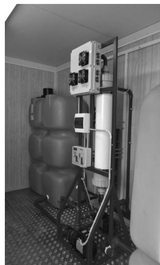
Рисунок 2 – Озонный генератор
